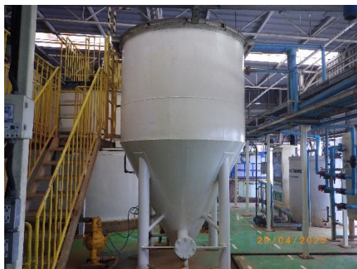
รูปที่ 2-24 ระบบบำบัดน้ำเสียทางเคมี
