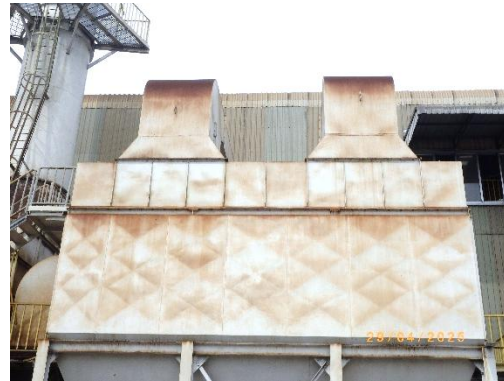
รูปที่ 2-11 Bag House Filter บริเวณการปั้นแบบและการขัดผิวชิ้น
