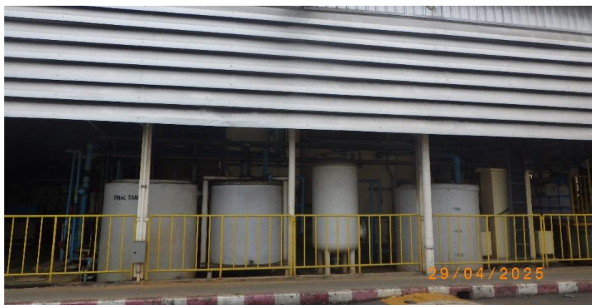
รูปที่ 2-23 ระบบบำบัดน้ำเสียสำเร็จรูป
