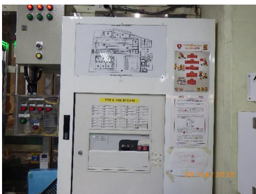
แผงควบคุมระบบสัญญาณแจ้งเหตุอัคคีภัย
