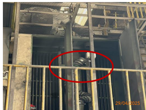
รูปที่ 2-7 เครื่องดูดอากาศ บริเวณการผสมทราย
