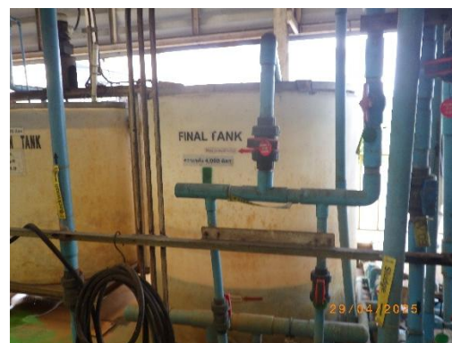
รูปที่ 2-26 ระบบบำบัดน้ำเสียทางเคมี ที่บริเวณ Final Tank
