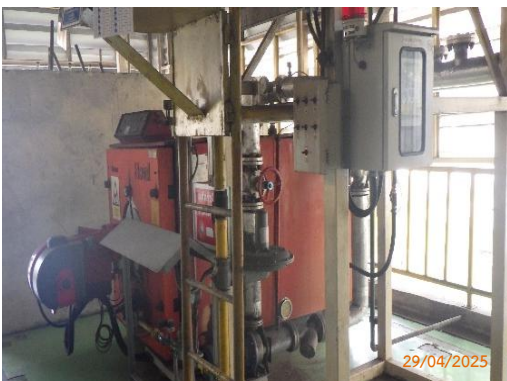
รูปที่ 2-14 ถังเก็บก๊าซธรรมชาติ (NG) เพื่อเป็นเชื้อเพลิงสำหรับหม้อไอน้ำ
