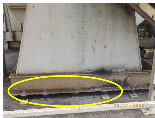
รูปที่ 2-21 แผ่นรองกันสะเทือน เพื่อลดเสียงและแรงสั่นสะเทือน
