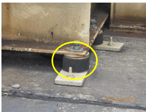
รูปที่ 2-21 แผ่นรองกันสะเทือน เพื่อลดเสียงและแรงสั่นสะเทือน
