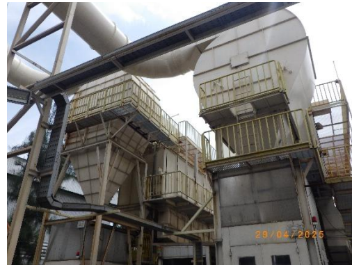
รูปที่ 2-5 เครื่อง Cyclone บริเวณการหลอมเหล็ก
